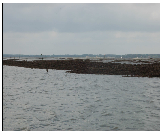
Figure 9 : Talus du chenal de Graveyron à marée basse (photo J.F Marailhac)
